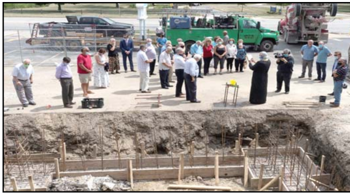
Αρκαδικό Σπίτι: Από την τελετή θεμελίωσης, επέκτασης και εκσυγχρονισμού του κτιρίου.
